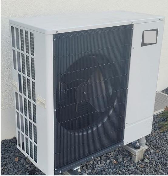
Bild: Eine Luft-Wärmepumpe ist klein und damit beliebig am Haus installierbar.
